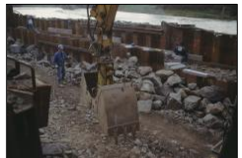
KZS.20 im Kanalbau
