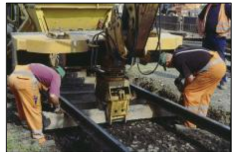
Einbringen der Neuschwellen
