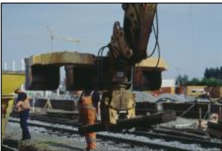
Entfernen der Altschwellen
