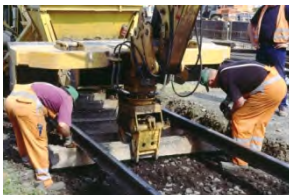
Einbringen der Neuschwellen
