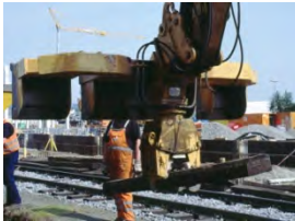
Entfernen der Altschwellen
